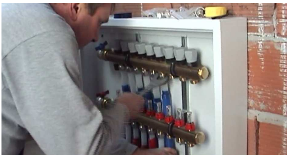
8. ábra: a nagy osztó-gyűjtő beszerelése
