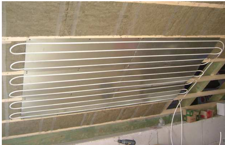
17. ábra: a panel tetőtéri alkalmazása
